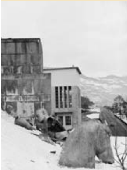
Reste des von Südtiroler Extremisten gesprengten Genio des Fascismo, bekannt als „Aluminiumduce“, bei Waidbruck im Eisacktal
