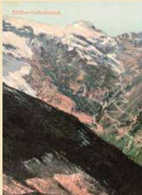
Die Stilfser-Joch-Straße – 1825 fertiggestellt
